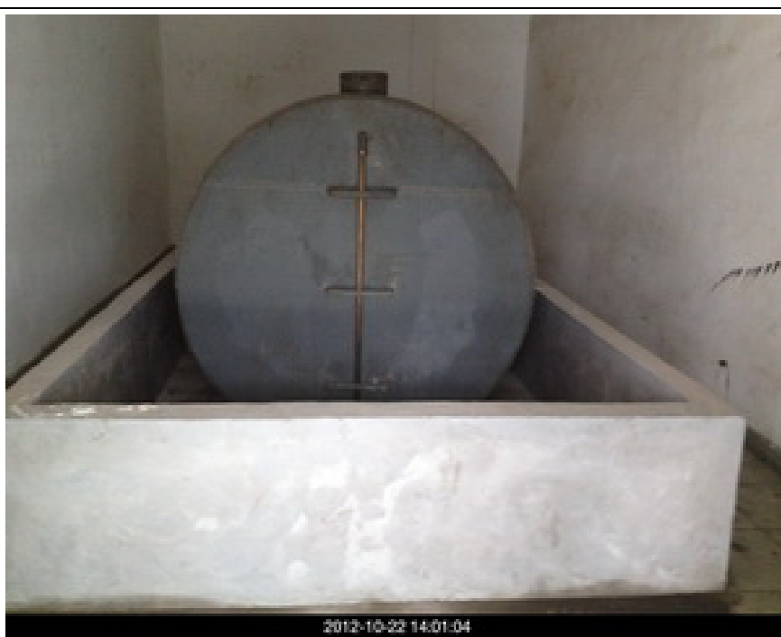
油罐有设置二次防漏设施。
