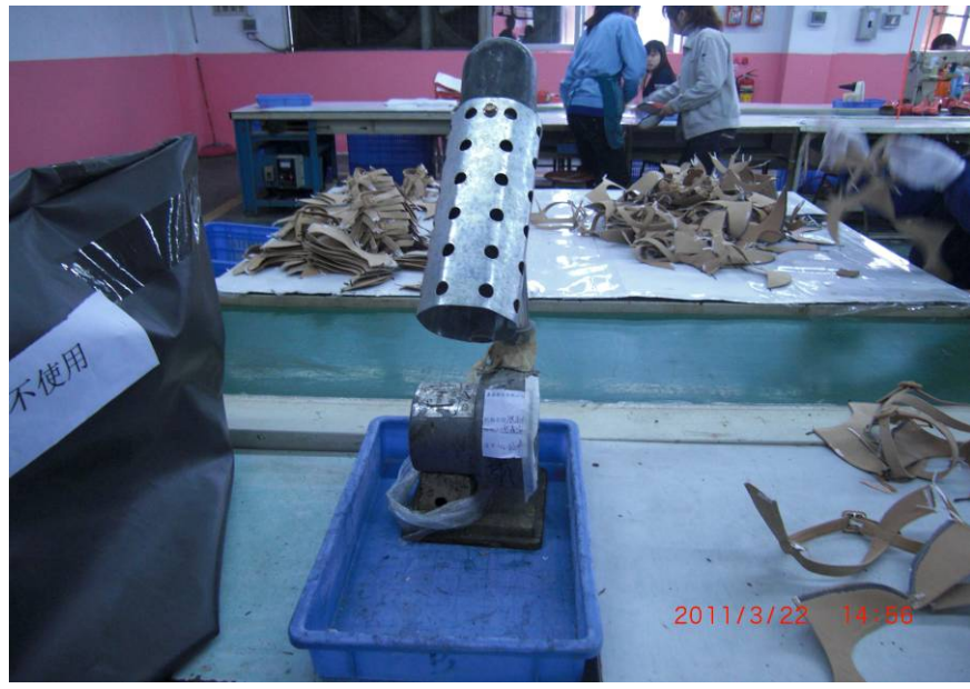
烘线机安装有隔热防护罩。
