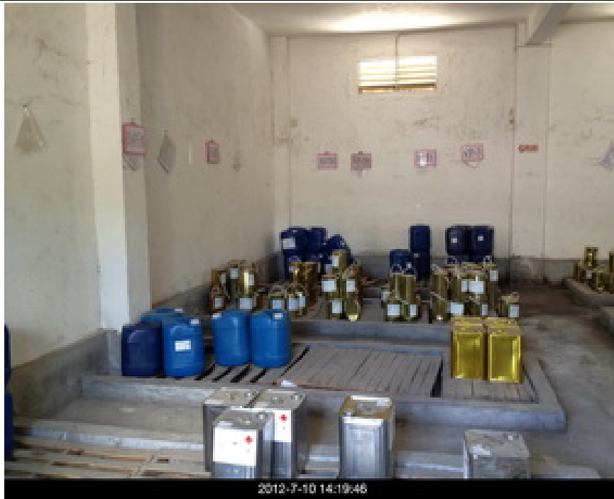
化学品仓库应具备二次防漏设施。
