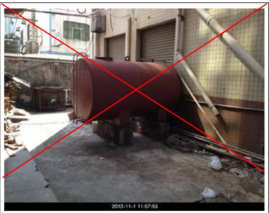
油罐没有设置二次防漏设施。
